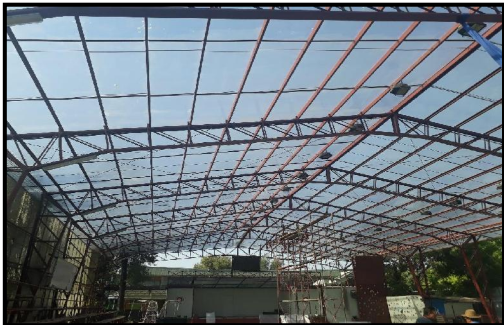
Cambio de cubierta en gimnasio Liceo Augusto D'halmar
