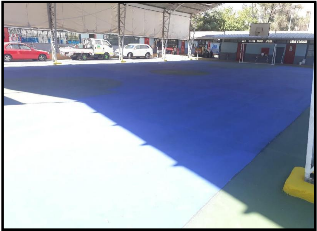
Mejoras en canchas Colegio Guillermo Zañartu
