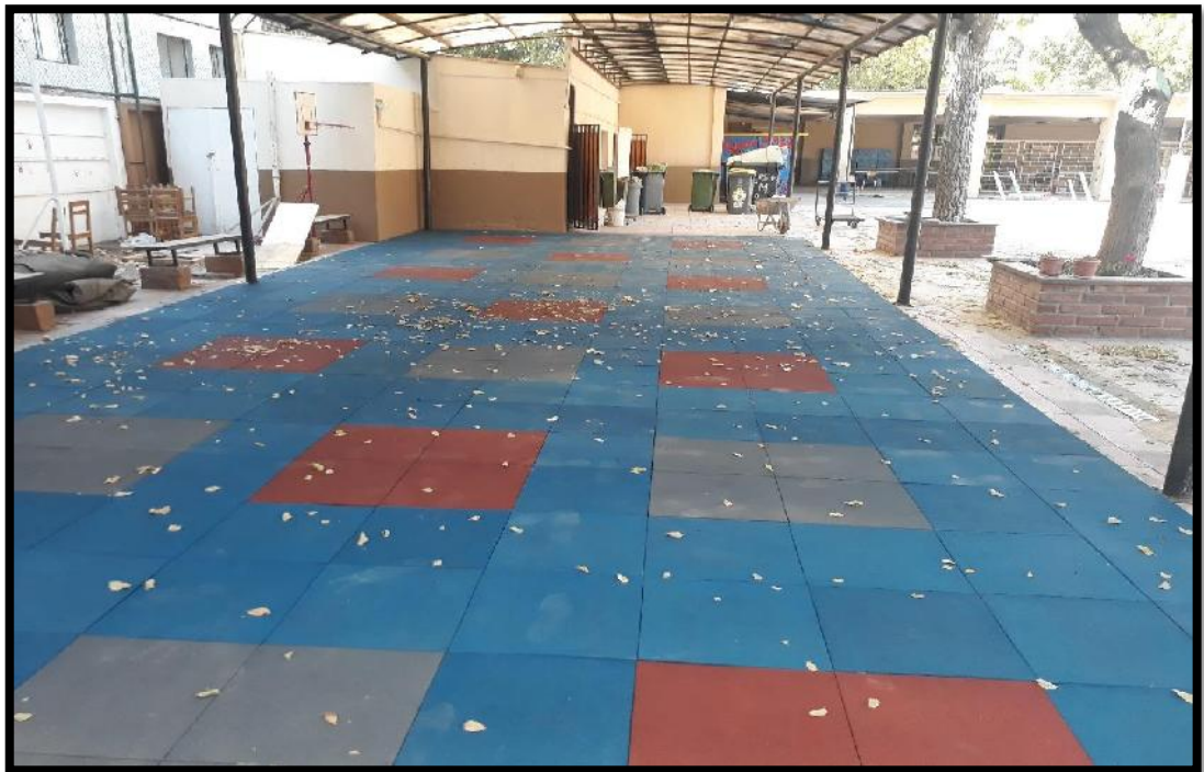
Pavimento patio de pre básica en Colegio José Toribio Medina
